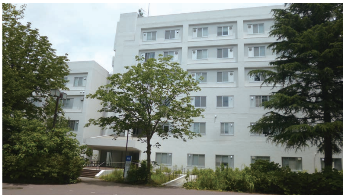
機械工学・材料棟
